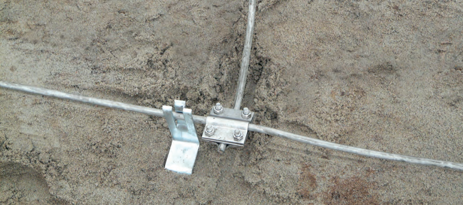
Uziom otokowy z elementem dystansującym
