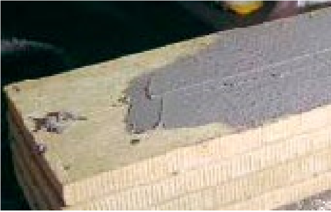
Pokrywanie zaprawą klejową tylnej powierzchni płyty PAROC CGL 20cy
