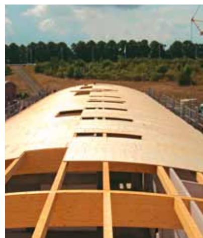
Przykładowa realizacja: poszycie dachu o bardzo dużej nośności.
