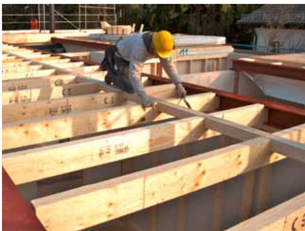
STEICO LVL R jako belka w konstrukcji stropu.
