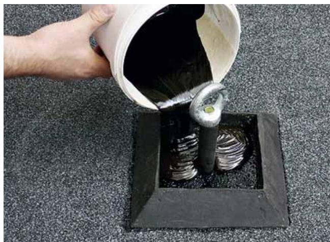
Fot. 20 Proces uszczelnienia wyjścia rury za pomocą metalowej ramki i uszczelniacza
