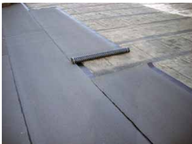
Fot. 22 Zmiana kierunku układania pap
