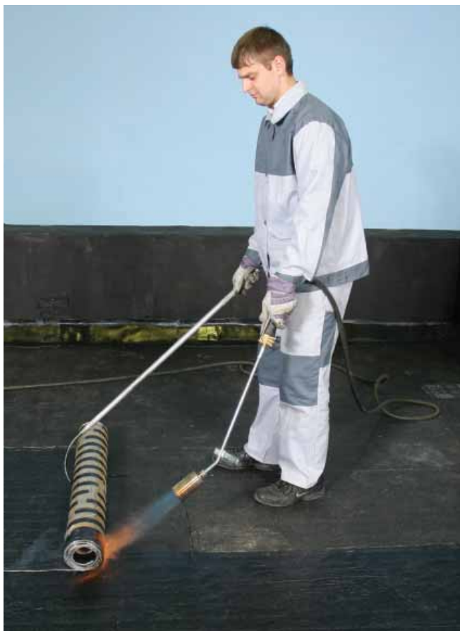
Fot. 14 Układanie papy MIDA REMONT SUPER
