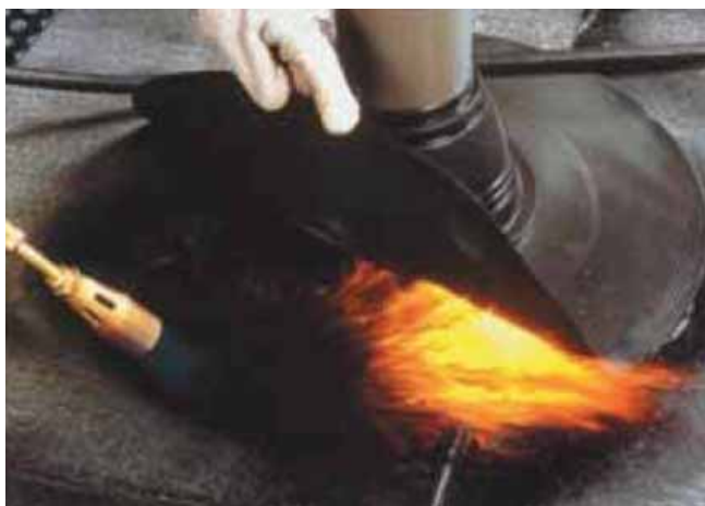
Fot.18 Obróbka rury
