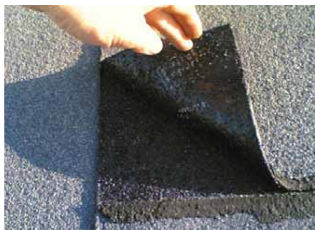
Fot. 26 Niedogrzenie papy podczas zgrzewania
