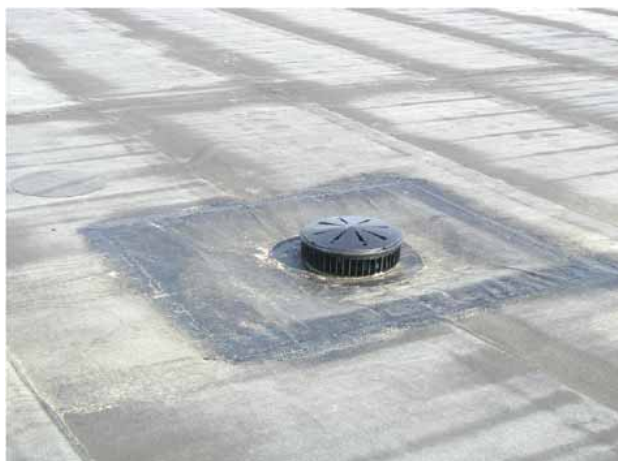
Fot. 17 Wpust dachowy
