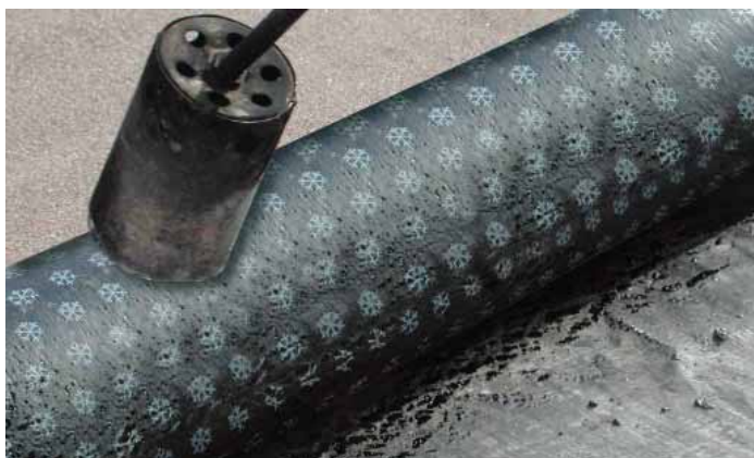
Fot. 9 Topienie grafiki na spodniej warstwie materiału podczas prawidłowego zgrzewania
