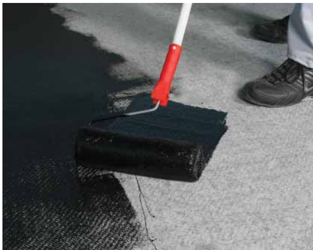
Rys. 2 Gruntowanie podłoża
