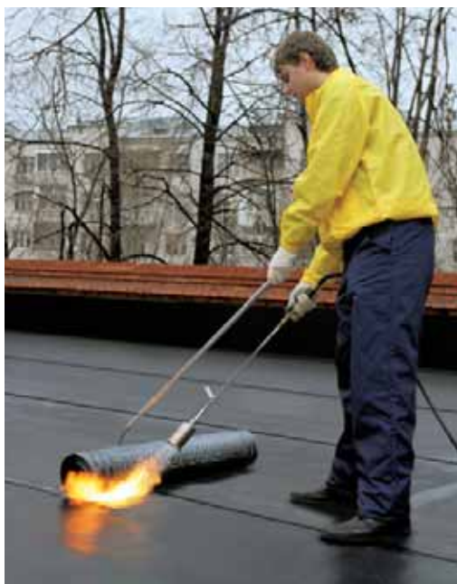
Fot. 8 Montaż papy termozgrzewalnej
