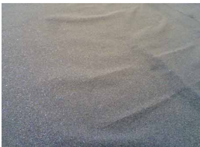
Fot. 28 Marszczenie się papy w wyniku błędu materiału
